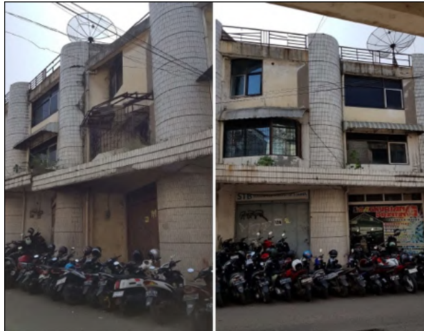
Keterangan : Kondisi Eksisting Ruko Kavling 12A-B
